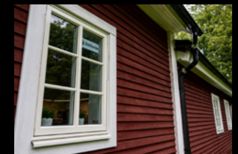
Lessebo Scoutkår, Lessebo Projekt: Fönsterbyte
