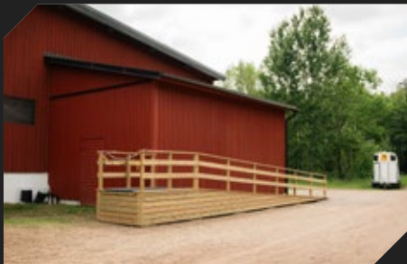
XL-BYGG MATERIALMÄNNEN Vimmerbyortens Ryttarförening Bygga en funktionsanpassad ramp
