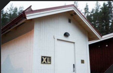
XL-BYGG FALU TRÄVAROR Ornäs Skidskytteförening Bygga en förrådsbod
